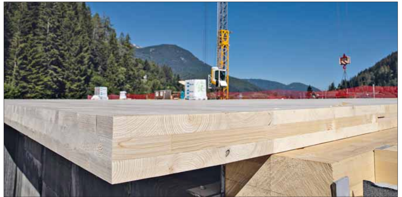
Drei-Schicht-CLT von Pfeifer im Querschnitt
