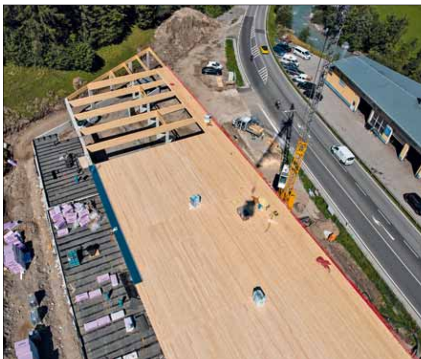
Dachfläche für die Werkshalle eines Recyclinghofes – komplett in CLT in Industriequalität
